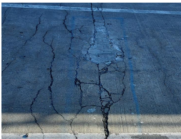
Exemple de réparations précaires de faible épaisseur et de délimitation non franches
