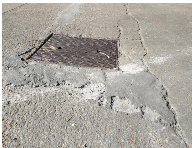
Exemple de réparations précaires de faible épaisseur et de délimitation non franches
