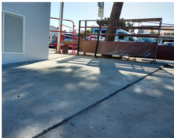
Décalage des éléments de dallage
