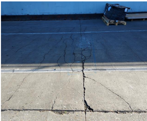
Fractures en bordures et en angles de dalles
