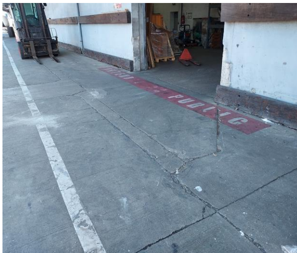
Fractures en bordures et en angles de dalles
