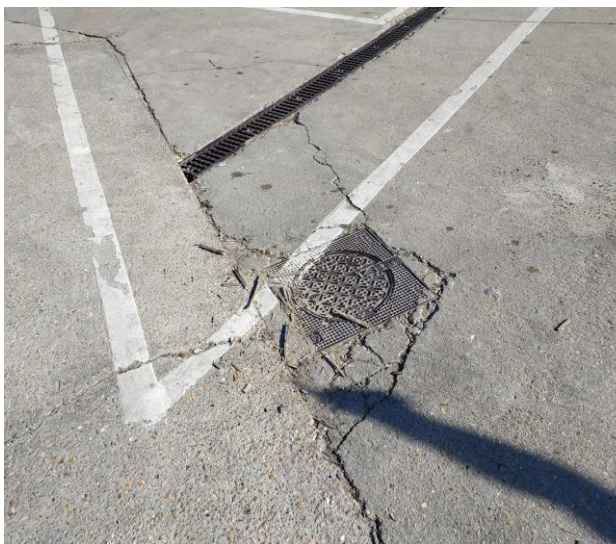
Fractures à proximité d'éléments intégrés aux différents réseaux
